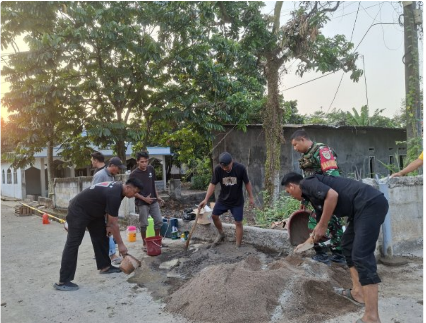
Pembuatan patok portal perlintasan kereta api jalan galur desa Cibening Purwakarta
